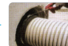
관을 감싸고 있는 고무 원통부위에 체결밴드(Sus Band)를 채운 후 나사를 조여 마무리합니다.
