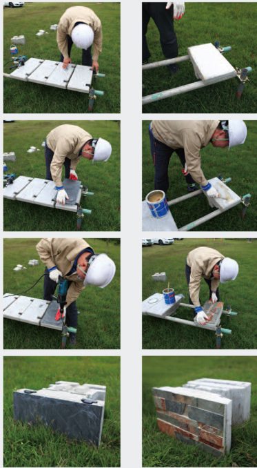
통판석재 부착(앵커볼트 조립)
